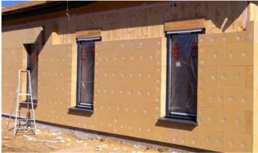
Figure : Isolation d'une maison avec de la fibre de bois ou de la ouate de cellulose. Source : Périgord Bois.
